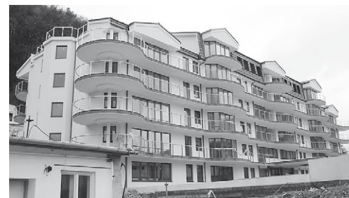
Gotowy budynek zrealizowany systemem szalunku traconego CETRIS® ▶
