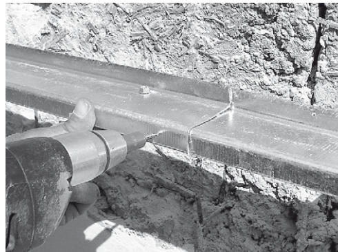
Złączenie profili Z50, wielkość zakładki 100 mm
