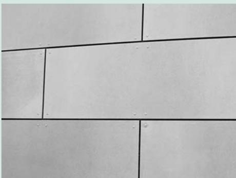
**A<sub>2</sub>) Sistema de fachadas CETRIS® PLANK** paneles con la junta horizontal solapada (visible sólo la junta vertical)
