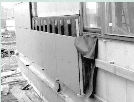
**B<sub>2</sub>) Esqueleto de perfiles de sistema en base de aluminio, chapa galvanizada (sistema EuroFox, SPEEDY, SPIDI, etc.)**
