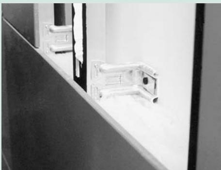
**B<sub>3</sub>) Emparrillado combinado** anclas + acoplamientos UNI + listones de madera
