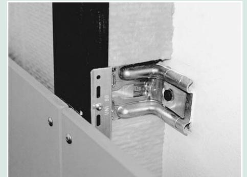
**B<sub>2</sub>) Tragrost aus Systemprofilen aus Alu oder aus verzinktem Blech**
