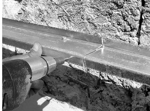
werden. Gleichzeitig mit der Montage der n-Profile den man den zweiten Teil des Basisprofils an den Wandfuß. Das Profil wird auf beiden Enden nach den Omega-Profilen ausgeglichen, es wird das Niveau geprüft und mittels Stellzange befestigt. Beide Teile des Grundprofils werden von unten nach 500 mm verschraubt. Danach wird die Diffusionsfolie zwischen Grundprofil eingelegt und die Omega-Profile werden zusammengeschraubt.
