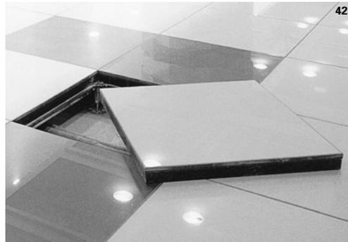
**Bild 18** Gymnasium Will, Schweiz CETRIS® BASIC, Decken- und Bodenkonstruktionen, schallisolierende (gebohrte) CETRIS® Platten
