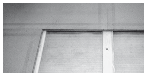
▼ Panneaux de plancher CETRIS® PDB sur les poutres
