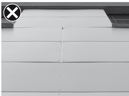
Překročená vzdálenost podpor
