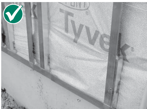
Richtige Montage der L-Profile in der Stelle der vertikalen Fuge
