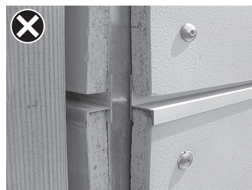
Nevyrovnaný podklad pod deskami
