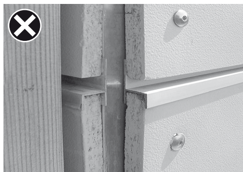
Schéma osazení pozinkovaných profilů při šířce desky <1875 mm
