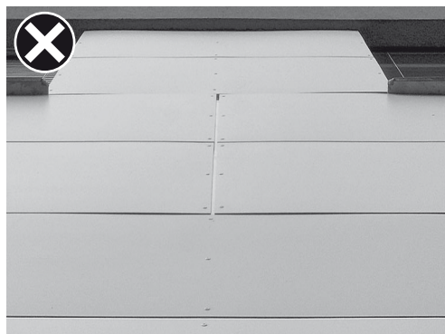
Dilatace – rošt z hliníkových nebo pozinkovaných profilů
